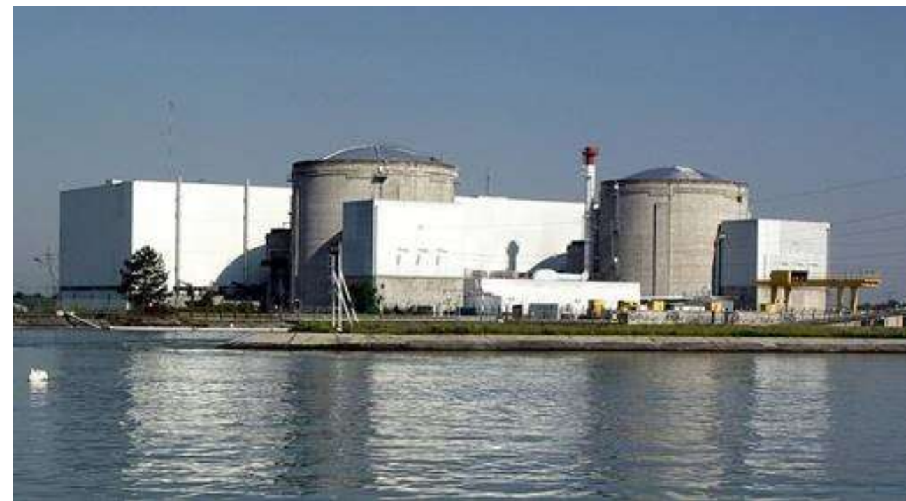
La centrale de Fessenheim
