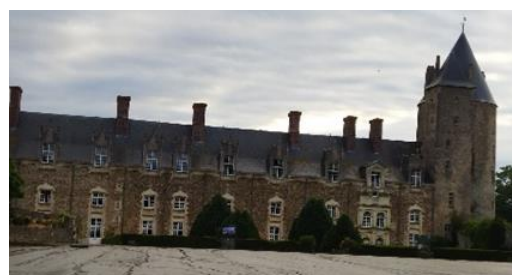
Château de la Groulais, à côté du gîte
